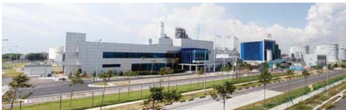
图 84: Neste 石油公司-新加坡商业化工厂
